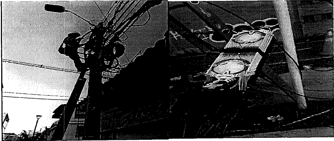
CONEXIÓN DE SERVICIOS
